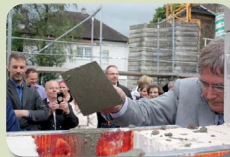
Pfarrer Thomas Bracht betätigte sich bei der Grundsteinlegung als Maurer.
